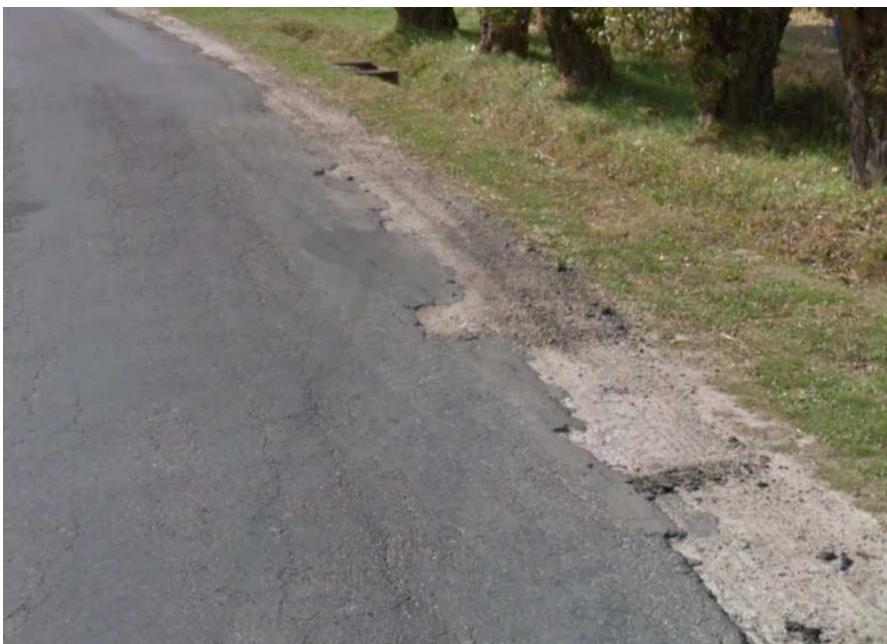
Zdjęcie nr 9 – uszkodzone krawędzie jezdni
