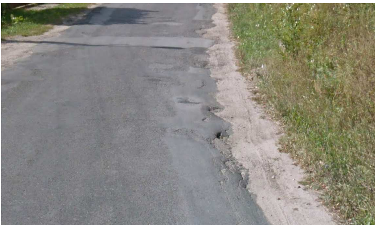
Zdjęcie nr 7 – koleiny, deformacje krawędzi jezdni
