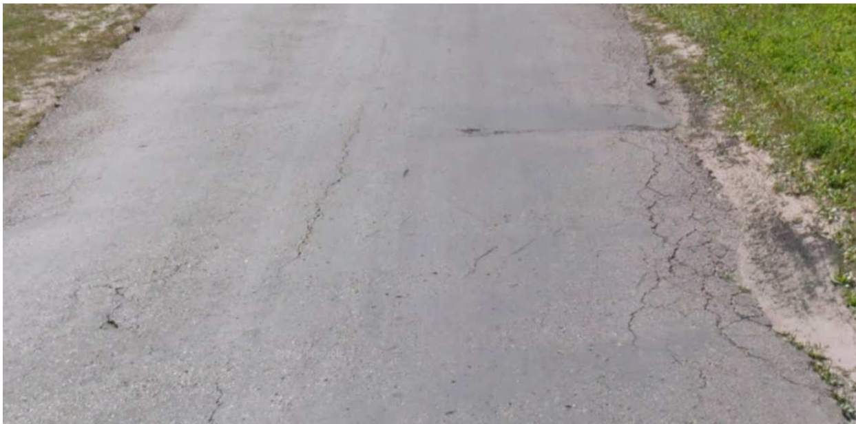
Zdjęcie nr 2 – spękania podłużne, poprzeczne, uszkodzenia krawędzi jezdni
