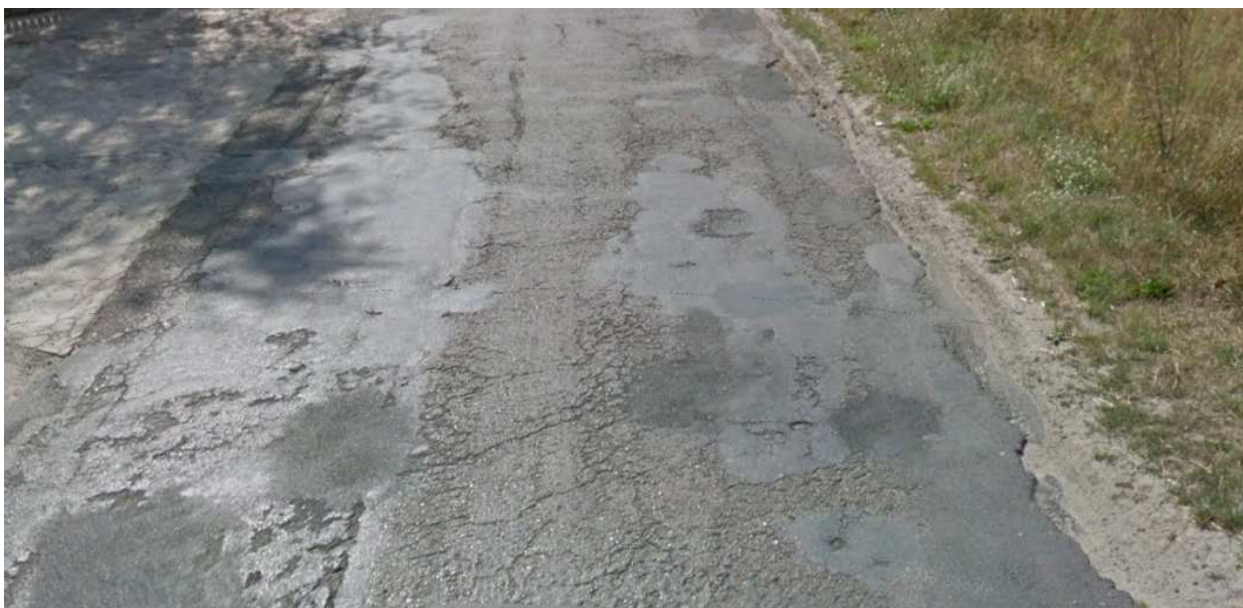
Zdjęcie nr 4 – liczne spękania podłużne i poprzeczne, brak warstwy ścieralnej, uszkodzone krawędzie drogi
