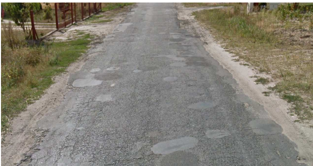
Zdjęcie nr 5 – liczne spękania i ślady po naprawach
