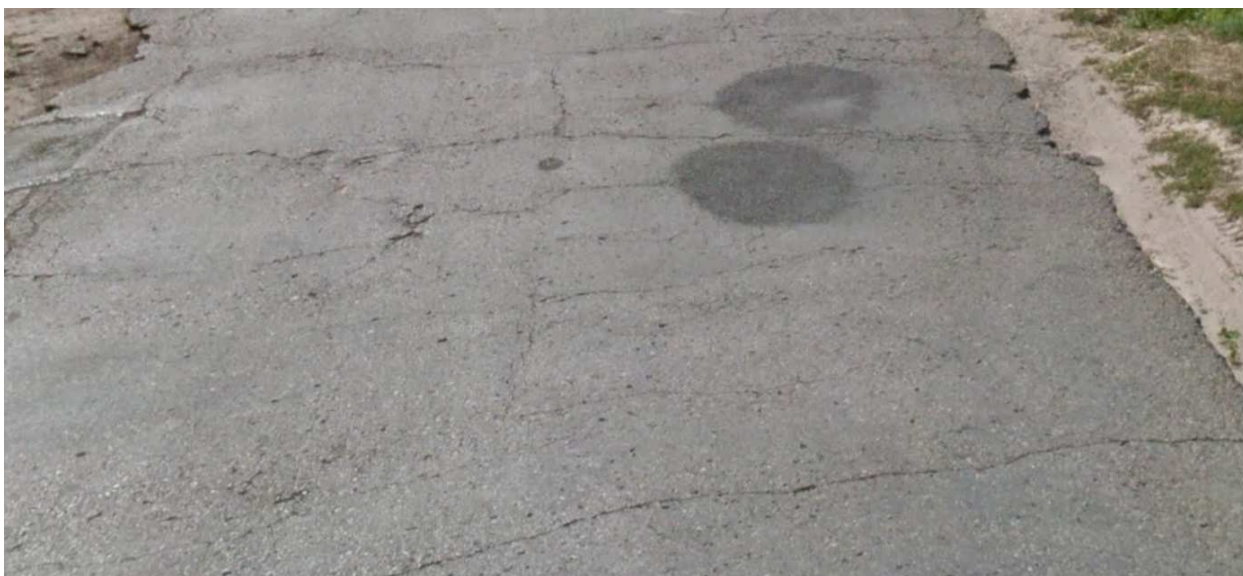
Zdjęcie nr 3 – spękania podłużne i poprzeczne, ślady po punktowych naprawach
