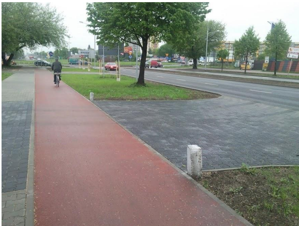
Fot. 1.1 Dobre praktyki - zachowanie ciągłości nawierzchni i niwelety drogi dla rowerów przez zjazd
