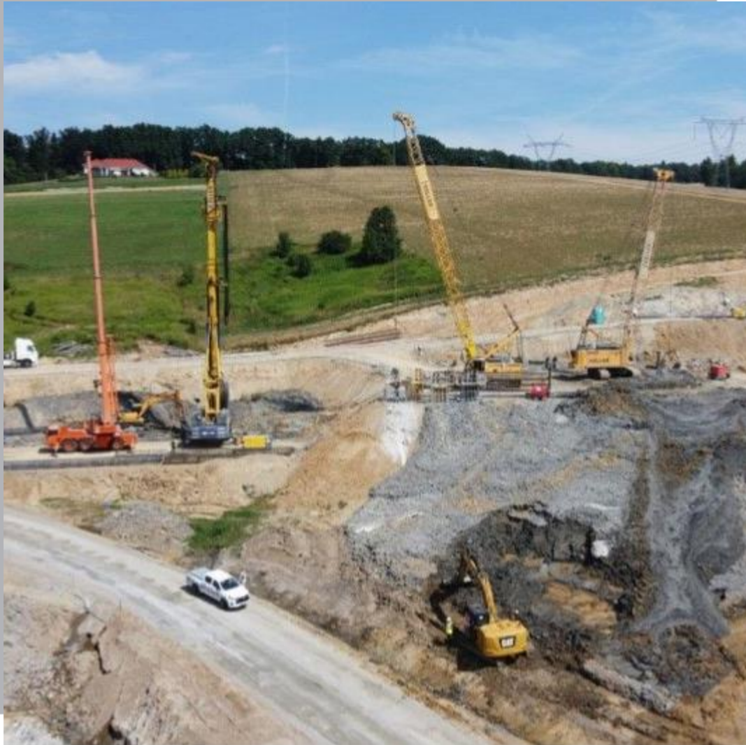
Widok na portal południowy tunelu
