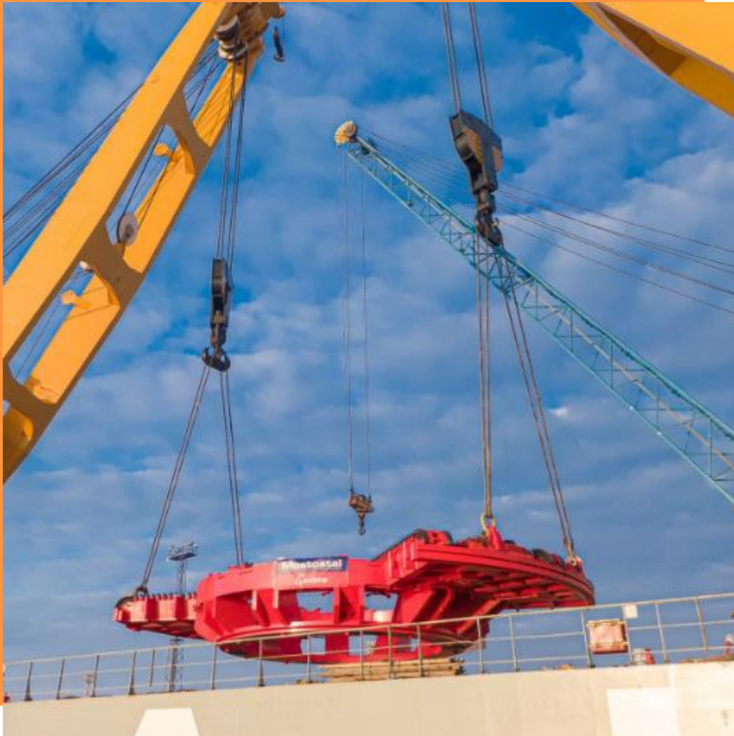
Rozładunek elementu maszyny
