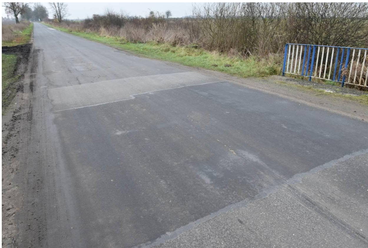
Fot. 3. Nawierzchnia na obiekcie bez uszkodzeń.
