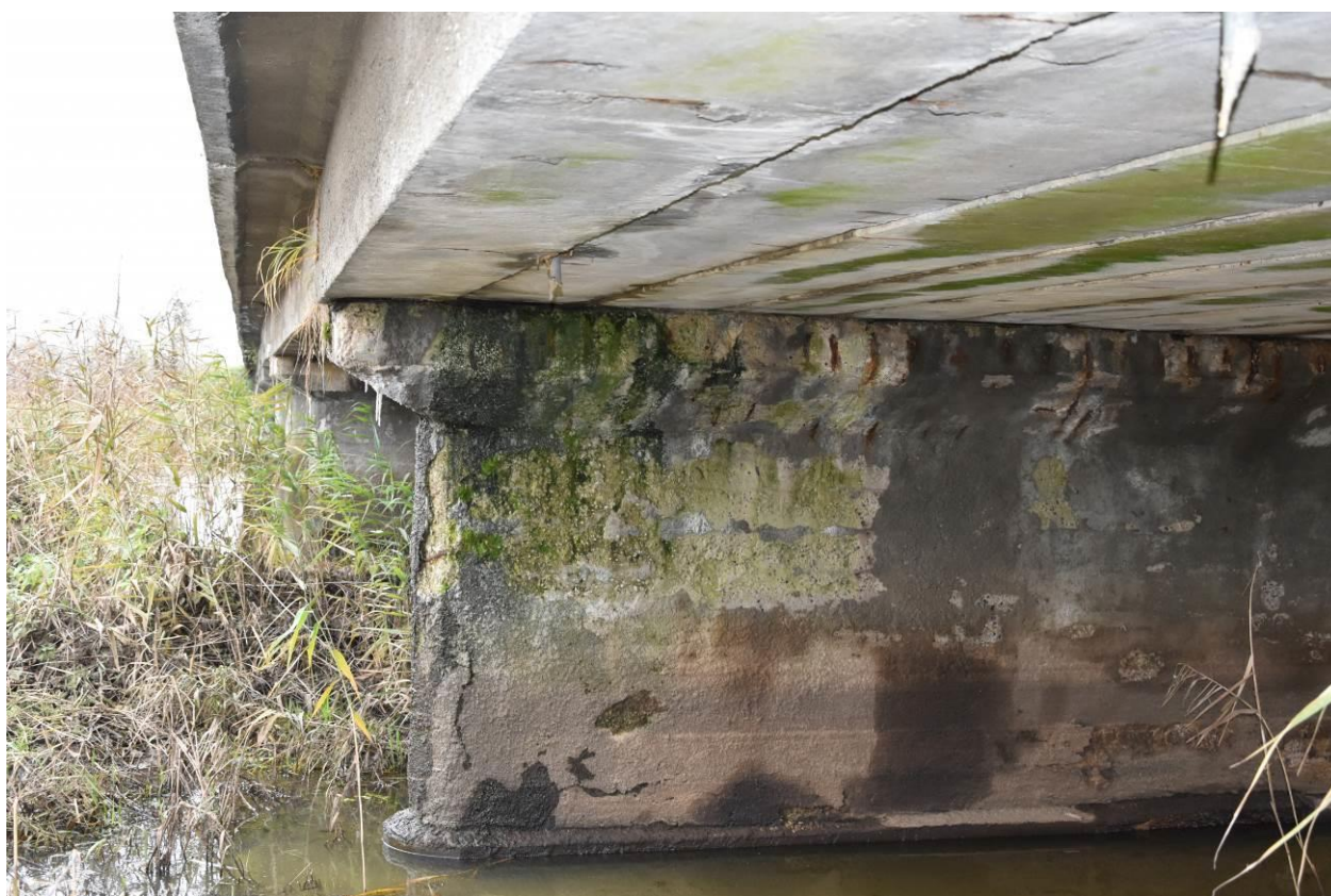
Fot. 6. Widok na podporę pośrednią. Występuje degradacja betonu oraz korozja stali zbrojeniowej.
