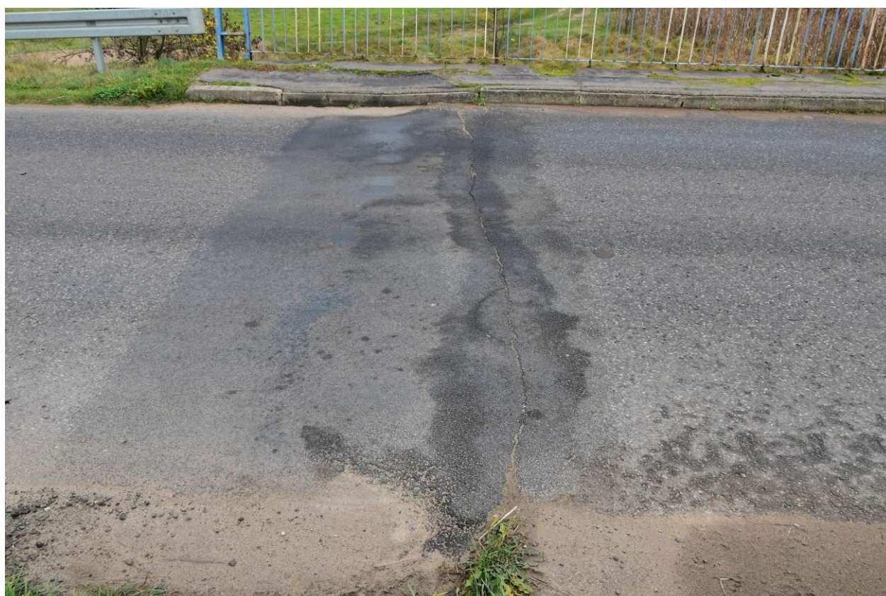
Fot. 10. Deformacja nawierzchni przy wjeździe na obiekt.
