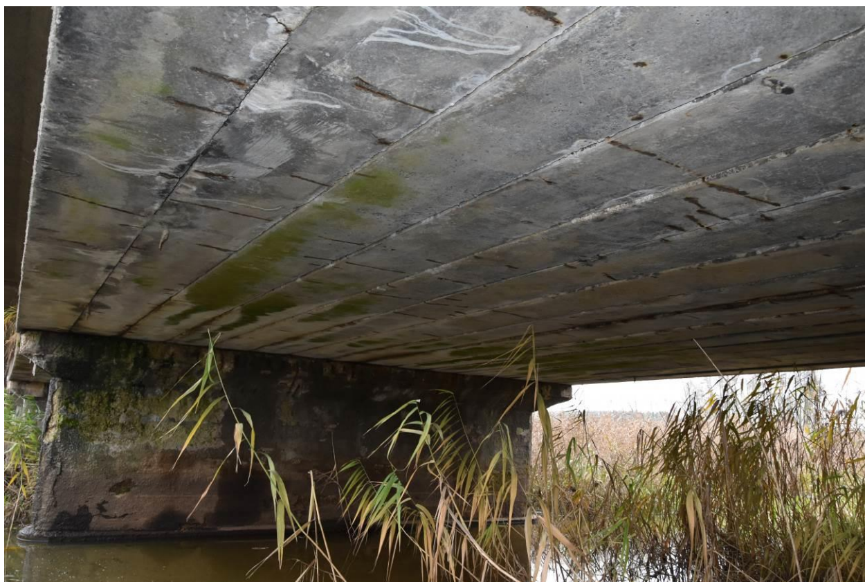
Fot. 12. Korozja prętów zbrojeniowych na dźwigarach.
