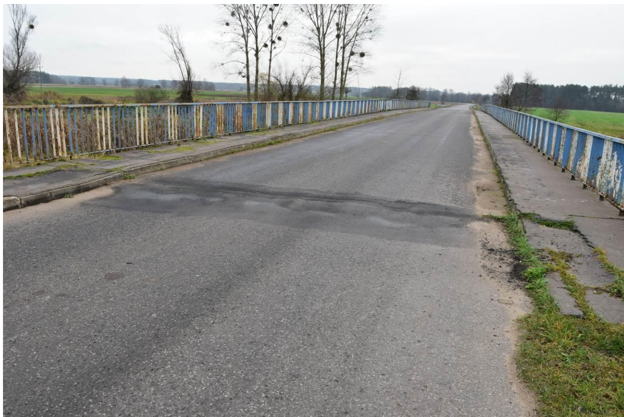
Fot. 1. Widok na obiekt i dojazdy. Deformacja nawierzchni na dojeździe. Wegetacja roślin na jezdni i chodniku. Zanieczyszczenia na jezdni.
