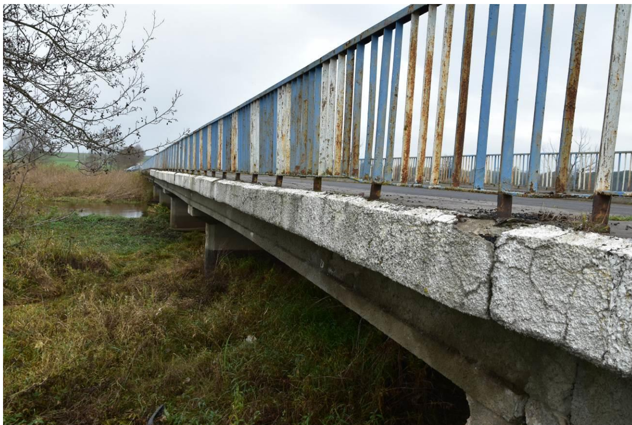
Fot. 3. Widok z boku. Korozja betonu gzymsów, korozja stali balustrad.
