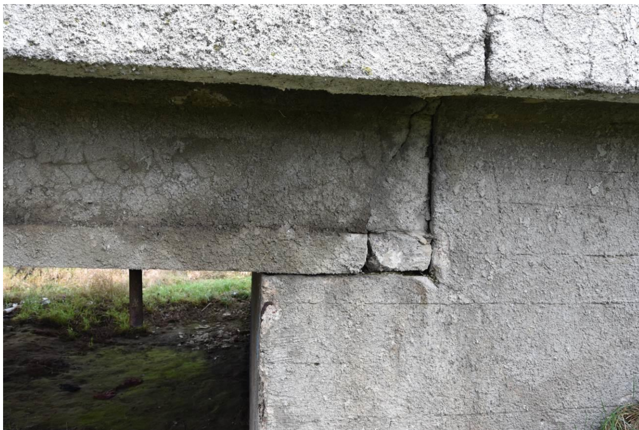
Fot. 11. Zarysowanie betonu na dźwigarze.
