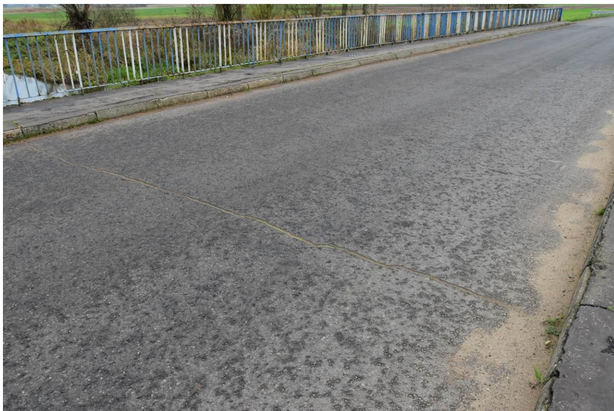
Fot. 2. Spękanie nawierzchni na obiekcie.
