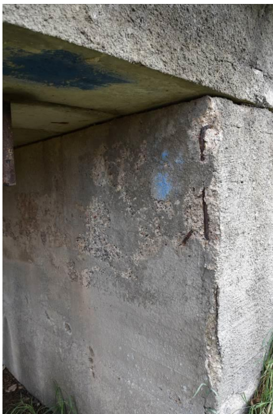
Fot. 9. Korozja i ubytki betonu na przyczółku.
