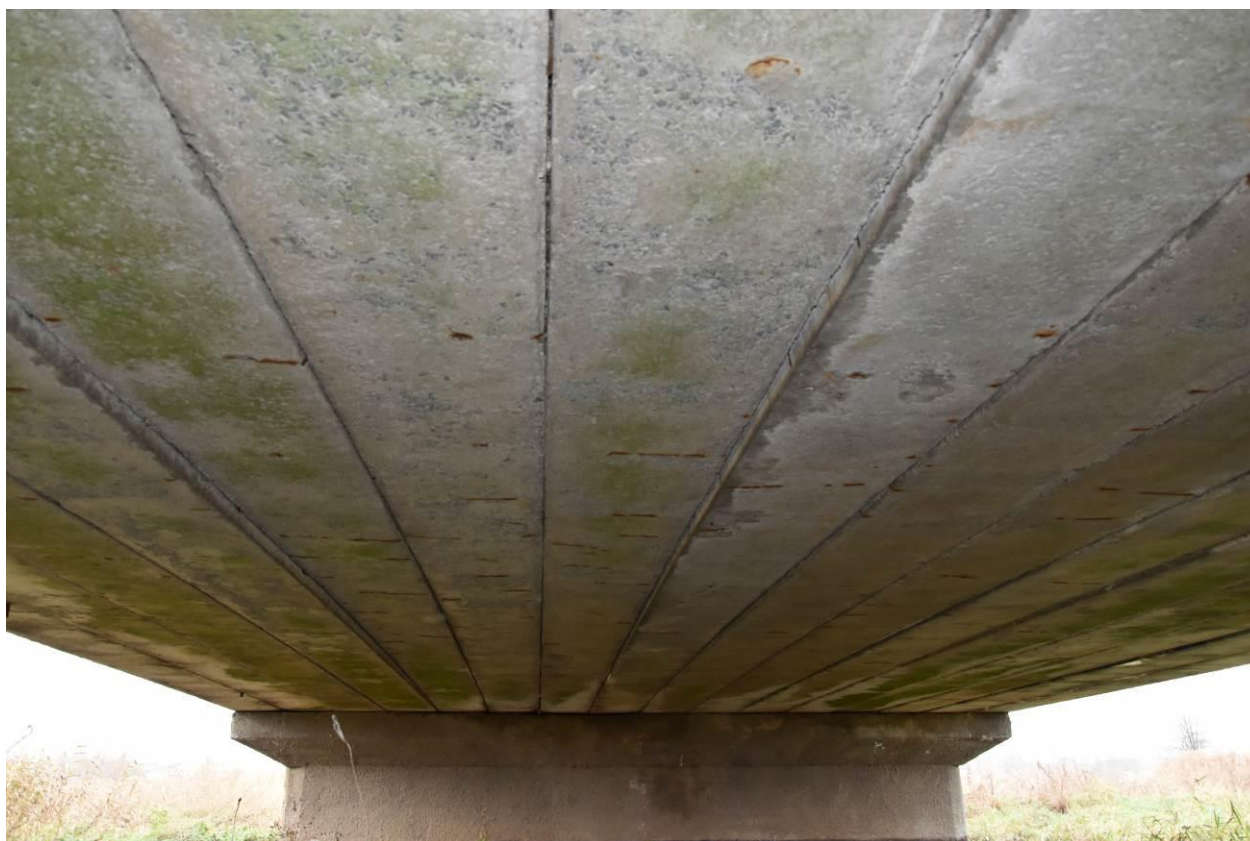
Fot. 4. Widok na ustrój nośny. Wykwity na powierzchni.
