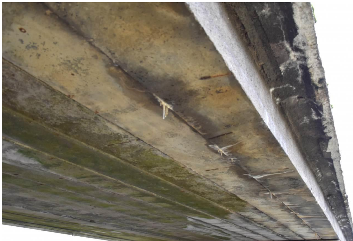
Fot. 5. Widok na ustrój nośny. Przecieki przez dźwigary, wykwyty, korozja betonu.
