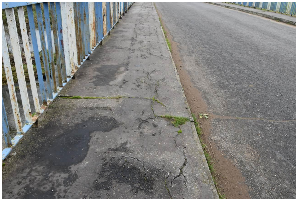
Fot. 8. Widok na chodnik. Spękania nawierzchni chodnika, wegetacja mchów. Korozja balustrady
