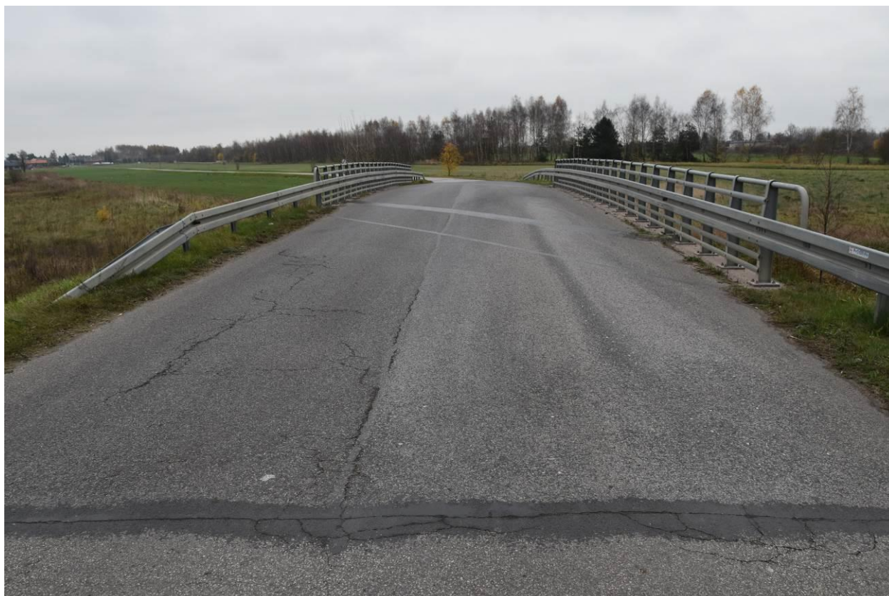
Fot. 1. Widok na obiekt. Spękania nawierzchni na dojazdach.
