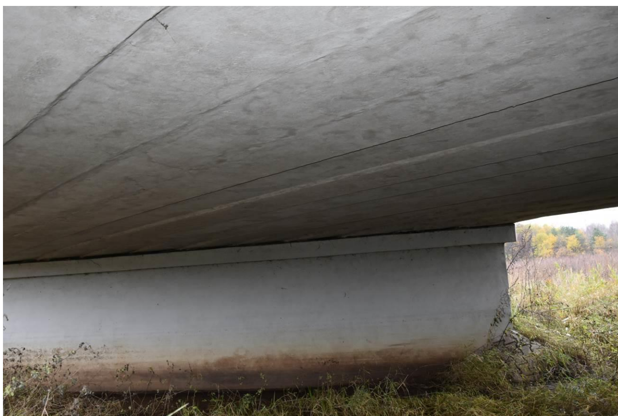
Fot. 4. Widok na podporę i dźwigar. Brak uszkodzeń.
