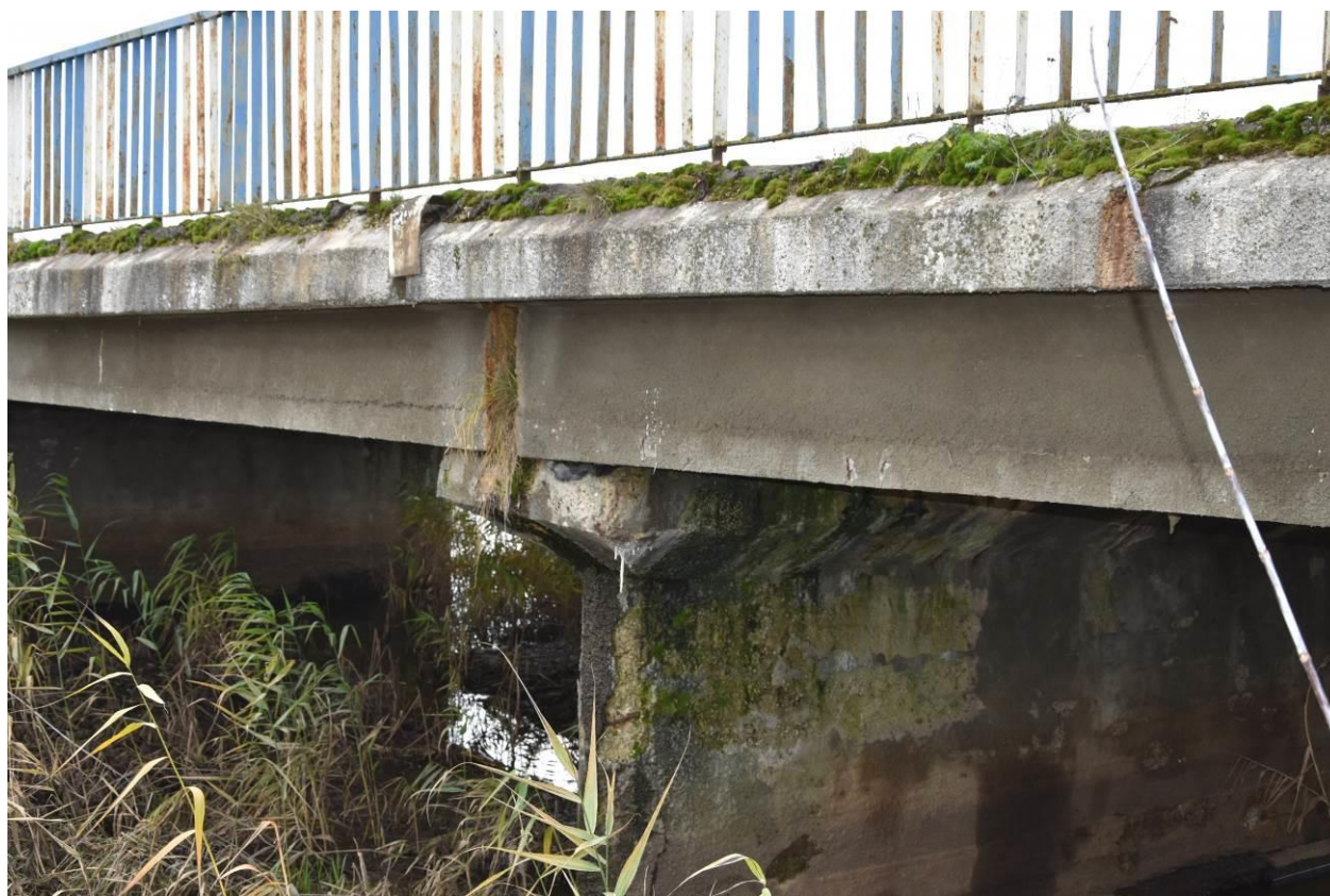
Fot. 7. Widok na podporę pośrednią. Występuje degradacja betonu oraz korozja stali zbrojeniowej. Wegetacja roślin na gzymsach i w szczelinie dylatacyjnej,
