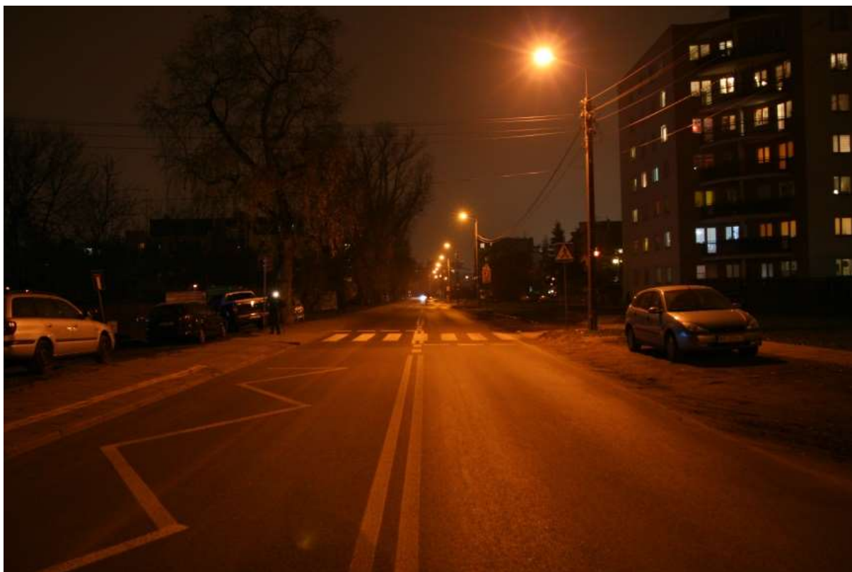
Rys. Z.8.1. Widok instalacji oświetleniowej – przykład 1
