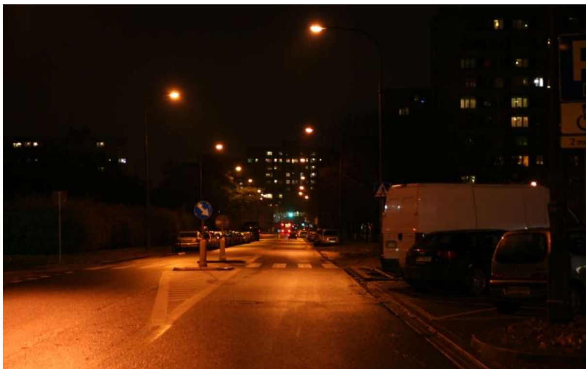
Rys. Z.8.2. Widok instalacji oświetleniowej – przypadek 2
