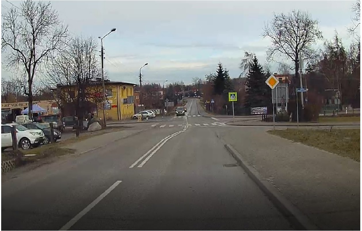
Droga powiatowa nr 3557W – wlot południowy
