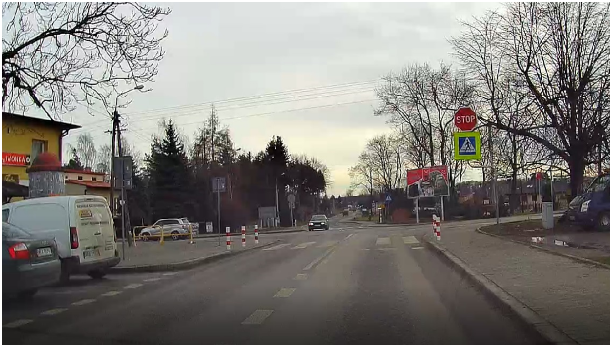
Droga powiatowa nr 3559W – wlot zachodni
