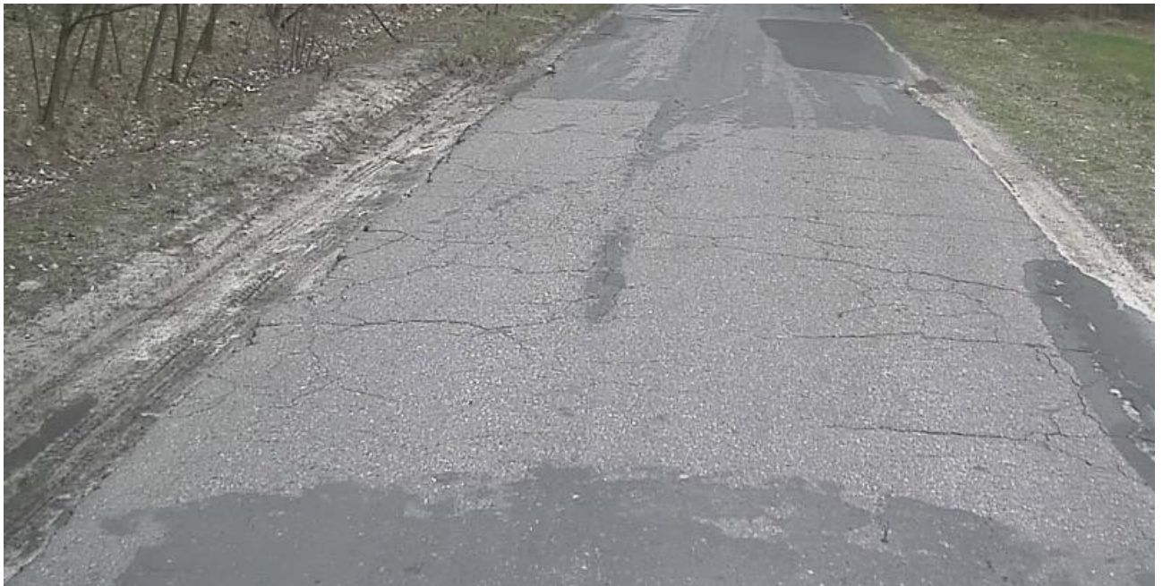
Rys. 3.2.1 Spękania poprzeczne oraz siatkowe warstw mineralno – asfaltowych. Widoczne pozostałości po zabiegach powierzchniowych
