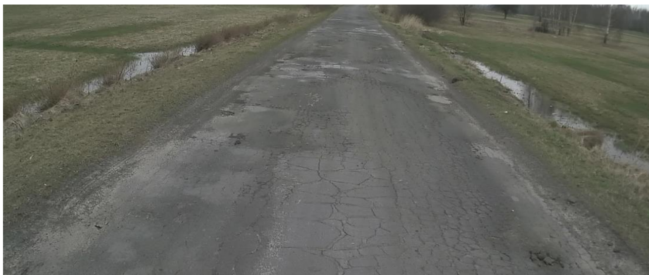
Rys. 3.2.4 Spękania, deformacje nawierzchni, zastoiska wodne przylegające do pobocza nawierzchni
