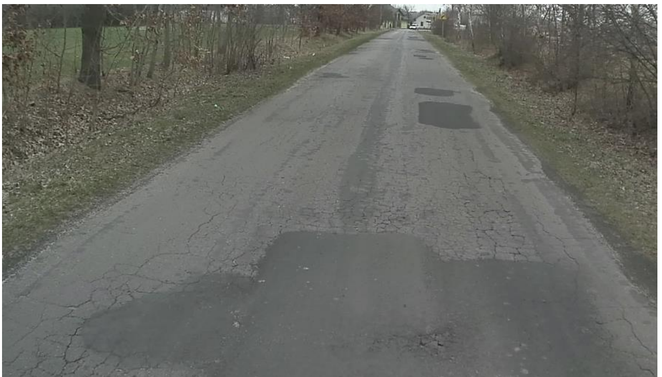
Rys. 3.2.3 Spękania siatkowe obejmujące znaczną powierzchnię pasa ruchu. Zawyżona krawędź pobocza uniemożliwiająca odprowadzenie wód opadowych poza pas ruchu.
