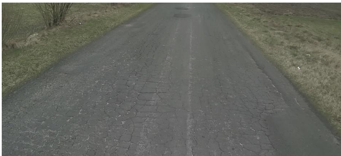
Rys. 3.2.5 Spękania siatkowe o małych okach na całej szerokości drogi.
