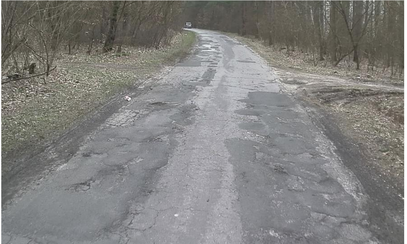
Rys. 3.2.2. Spękania, deformacje strukturalne, widoczne naprawy powierzchniowe.
