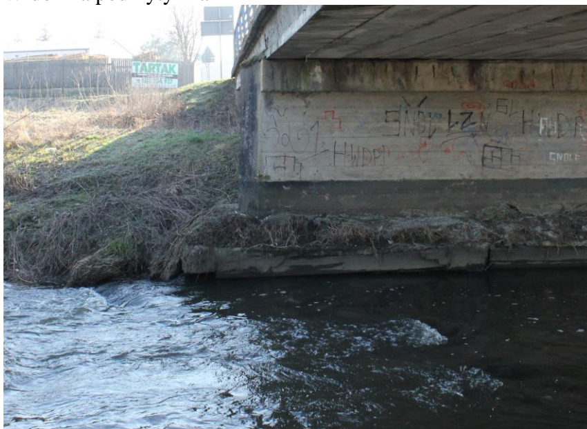
Fot. 1 Widok na podmyty filar
