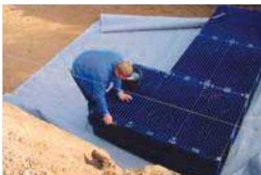
Rys. 2 Owijanie geowłókniną skrzynek rozsączających.
