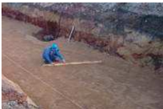
Rys. 1 Sprawdzenie równości dna wykopu.
