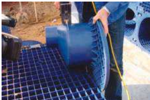
Rys. 4. Montaż złączek redukcyjnych do podłączenia przykanalików dn 160.
