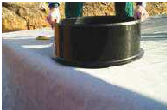
Rys. 6. Montaż zintegrowanej studzienki inspekcyjnej.
