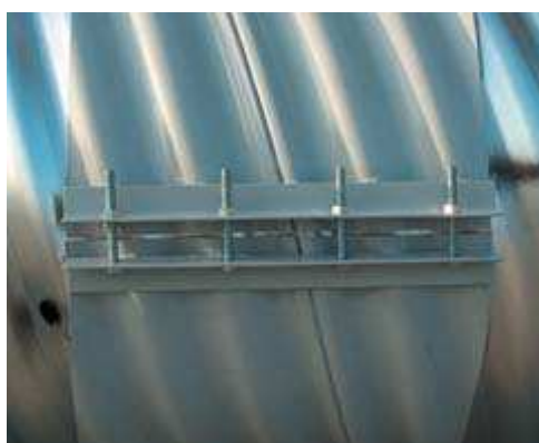
Rys. 2 Zamontowana opaska karbowana.
