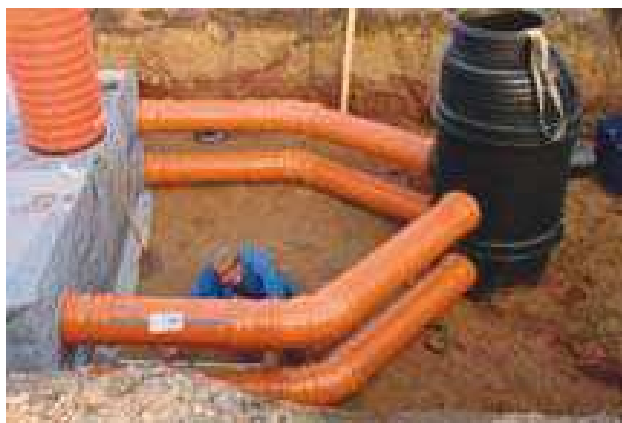
Rys. 7. Podłączenie przykanalików.
